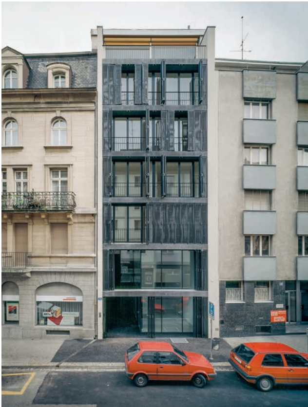
Kontrastreiche Interpretation: Herzog & de Meuron, 1992, Wohn- und Geschäftshaus an der Schützenmattstrasse, Basel. Das Gebäude besetzt eine schmale und tiefe Baulücke. «Die strassenseitige Fassade ist ganz verglast», so die Architekten (Herzog & de Meuron 1970–1988, Das Gesamtwerk Band 1, Birkhäuser Verlag Basel, 025 Apartment and Commercial Building, Schützenmattstrasse Basel, S. 85), «vor die Glasfassade sind geschosshohe Faltläden montiert, die eine zweite Haut vor das Gebäude spannen. Ihr schweres Gusseisen gibt dem Haus in der Strassenflucht eine starke Präsenz und wirkt zugleich wie ein Schutzfilter gegen den Lärm und die Blicke von der Strasse und den gegenüberliegenden Häusern.» Erscheint die mehrschichtige Fassade zunächst fremd, zeigt der zweite Blick Eigenarten: Das Muster der Faltläden etwa erinnert an Dolendeckel und Baumscheiben, eine Reminiszenz an das Gewöhnliche im Quartier. Foto: Margherita Spiluttini, Architekturzentrum Wien, Sammlung (3255b-b)
