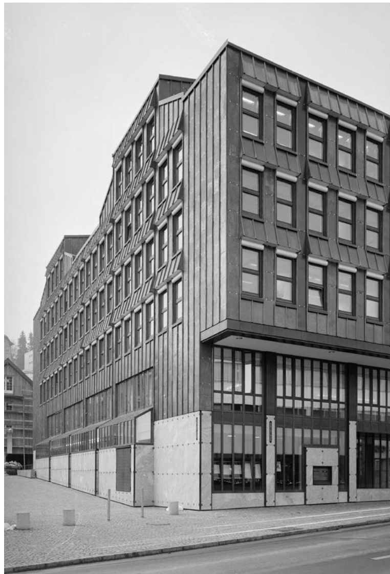
Nachahmende Interpretation: Ernst Gisel, 1981, Kantonalbank am Obstmarkt, Herisau. Eine spätgotische Kirche und Bürgerhäuser aus dem 18. Jahrhundert flankieren das aus einem zweistufigen Wettbewerb hervorgegangene Bankgebäude. Die Architektur ist selbstbewusst, interpretiert aber den Standort und die regionale Bautradition mit neuzeitlichen Mitteln. Massstab, Struktur und Klebdächer der Bleifassade sind auf diese Weise hergeleitet. Blei patiniert hell, sodass sich seine Farbigkeit an die Fassaden verschindelter Häuser anlehnt. Im Gegensatz dazu sind die tragenden Stützen mit nachdunkelndem Kupferblech verkleidet. Sie erinnern an die Pilaster, die das Fronttäfer vieler Appenzeller Bürgerhäuser gliedern und auf den dahinter liegenden Strickbau verweisen. Fotos links: Gäbi Lutz, GTA-Archiv, ETH Zürich, Vorlass Ernst Gisel. Foto rechts: Vorlass Georg Gisel
